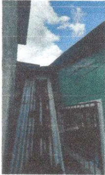
Foto 1: Cubierta de lámina. Sustrucción de lámina por lámina troquelada aluzinc calibre 26. Sustrucción de elementos de fijación
