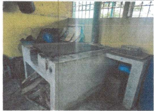
Foto 8: Reparación de cocina. Mantenimiento a estufa rural. Sustitución de plancha de metal de 3 hornillas.
