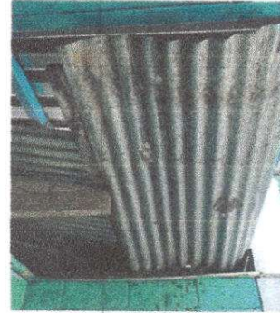
Foto 2: Estructura de techo. Sustrucción de soportes de madera por metal
