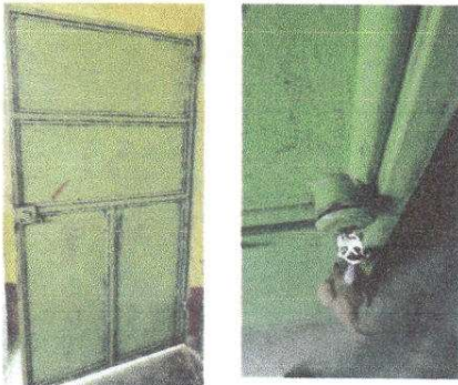
Foto 3: Puertas de metal. Mantenimiento a la estructura. Sustrucción de chapas. Sustrucción de puerta en cocina.
