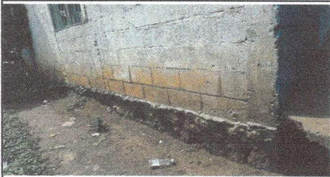
Foto 9: Reparación de cuneta de concreto
