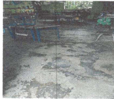
Foto 4: Piso. Sustrucción de piso torta de cemento líquido por piso cerámico.
